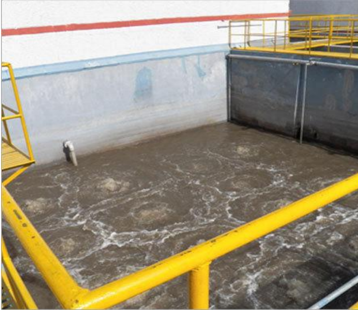
Hình 4.6. Bể điều hòa và bơm chìm nước thải
