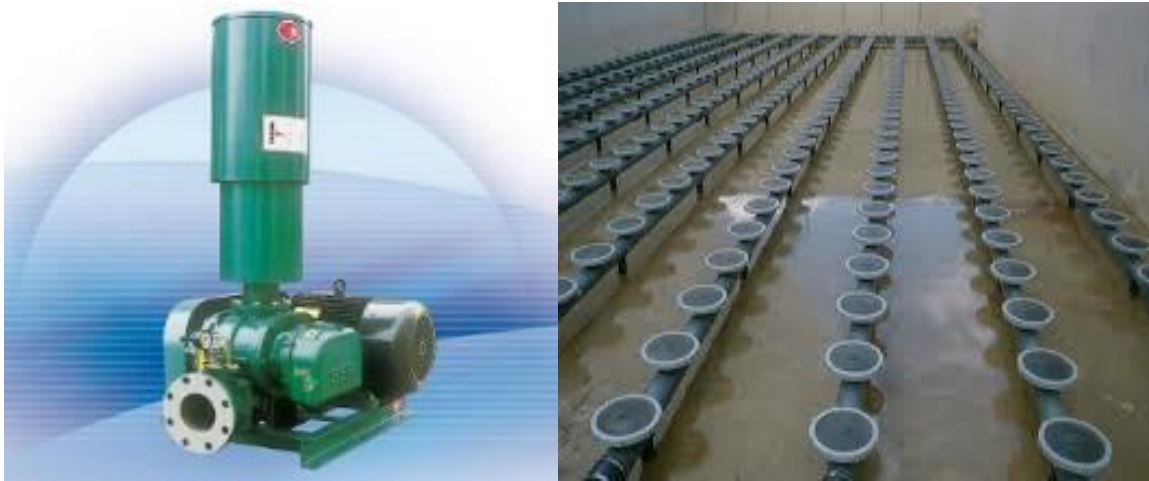
Hình 4.11. Máy thổi khí và hệ thống phân phối khí
